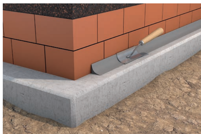
1.4 Hohlkehle setzen (INTRASIT® RZ1 55HSP oder INTRASIT® FSM Winter 56Z)
