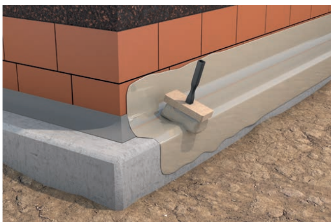
1.5 Freigelegtes Mauerwerk inklusiv Bodenplatte 2-lagig schlämmen (INTRASIT® RZ1 55HSP oder INTRASIT® DS1 54Z)
