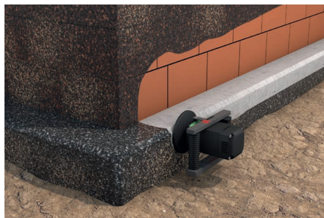
1.2 Boden-Wand-Anschluss von alter Abdichtung befreien (mechanisch)
