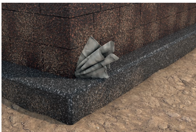
1.1 Prüfen, ob Altabdichtung aus Bitumen oder Teer (Reibprobe mit Lappen)
