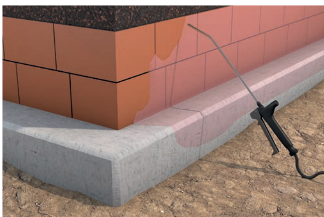
1.3 Freigelegtes Mauerwerk grundieren (z. B. IMBERAL® Aquarol 10D)
