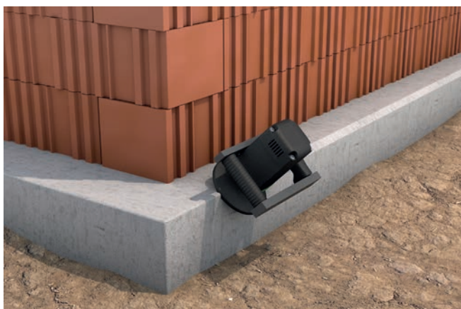
1.1 Senkrechte und waagerechte Kanten anfasen (Betonschleifer)
